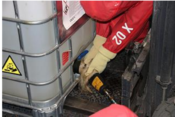
Auffangen und Abdichten des Schadstoffaustritts am Gefahrgutcontainer
