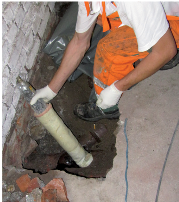
Einführung des Kurzliners in die defekte Leitung
