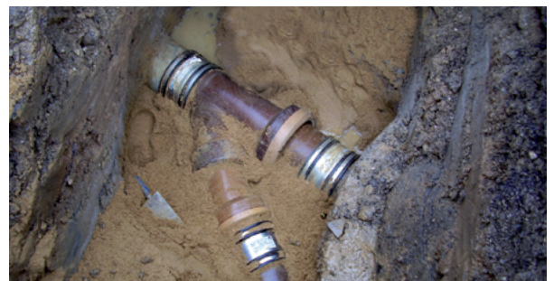
Reparatur einer Leitung in offener Baugrube
