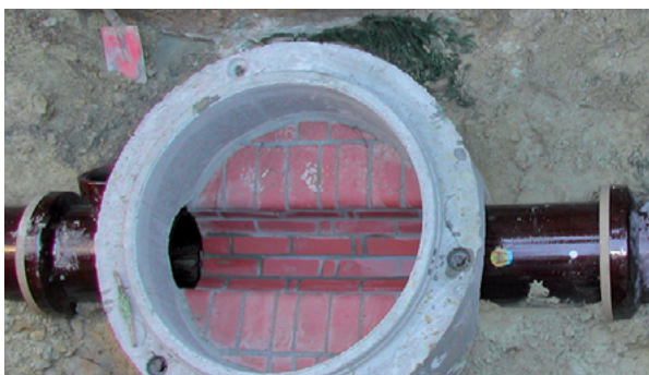
Einbau eines Revisionsschachtes
